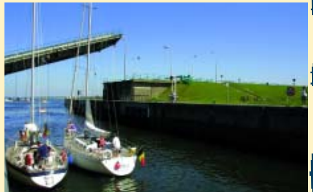
LE PONT-LEVIS DE L'ÉCLUSE DE ZANDKREEKSLUIS LAISSE ÉCHAPPER LA PETITE DIZAINE D'UNITÉS Sagement rangées dans l'impressionnant ouvrage.
